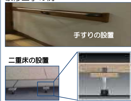
改修工事の例
